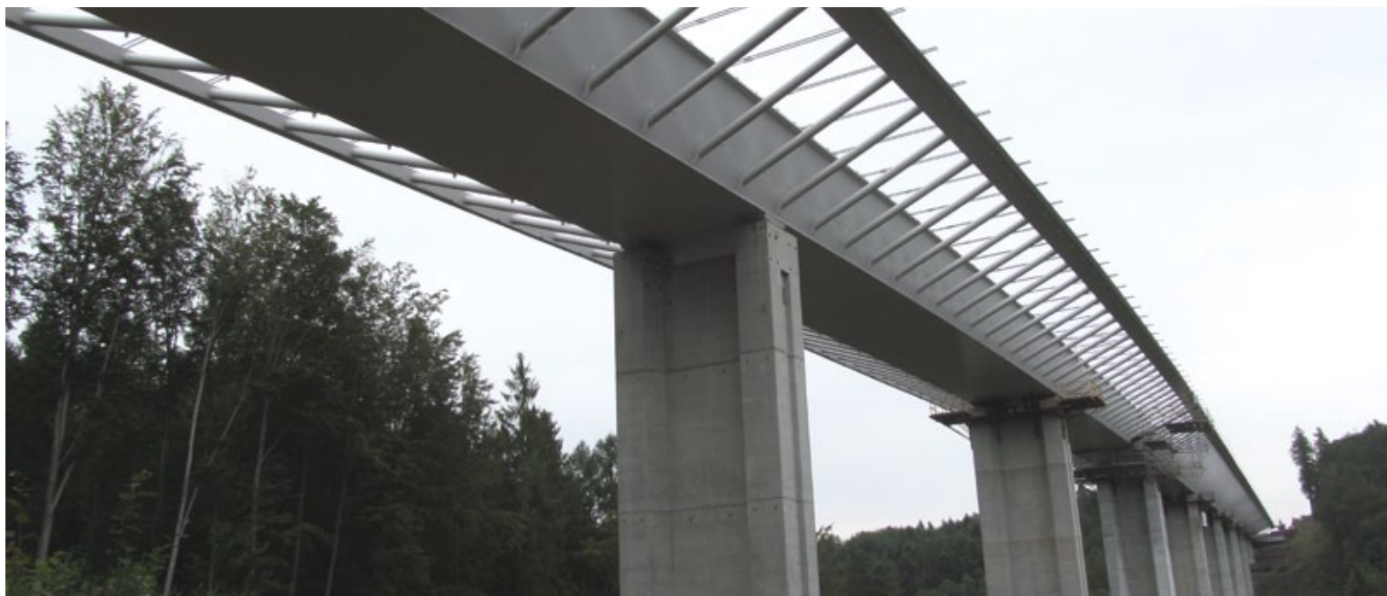
Cesta do Ostravy bude rychlejší i díky impozantnímu mostu přes údolí Kremlice nedaleko Josefov. FOTO: ARCHIV SDRUŽENÍ PRO VÝSTAVBU
